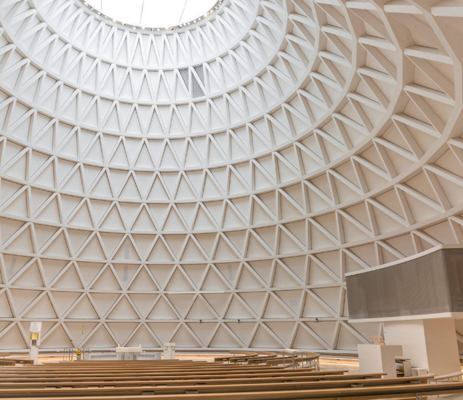
INNOVATION IN DER KIRCHE: Die Pfarrkirche St. Josef in Holzkirchen hat von Amann eine imposante Holzkuppel erhalten
