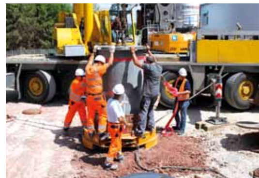
Mit einer Länge von 20 Metern und 1,10 Metern Durchmesser fasst dieser Hochleistungsenergiepfahl ein Wasservolumen von 19 Kubikmetern
